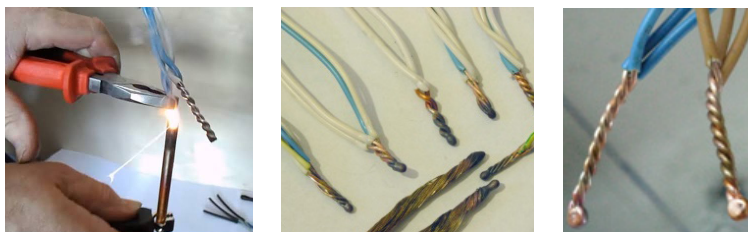
Рис. 41. Сварка электромонтажных соединений
