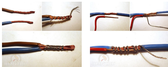
Рис. 49. Скрутка проводов с использованием бандажа
